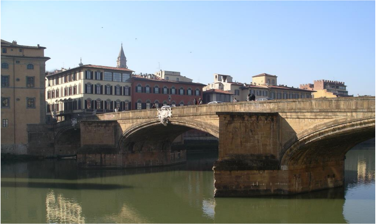
Fig. 2 Il ponte di Santa Trinita, opera di B. Ammannati (1567-1571), su probabile consulenza di Michelangelo, distrutto nel 1944 e ricostruito nel 1958 in "pietra forte" (ricollocate le statue e le decorazioni ripescate in Arno)
