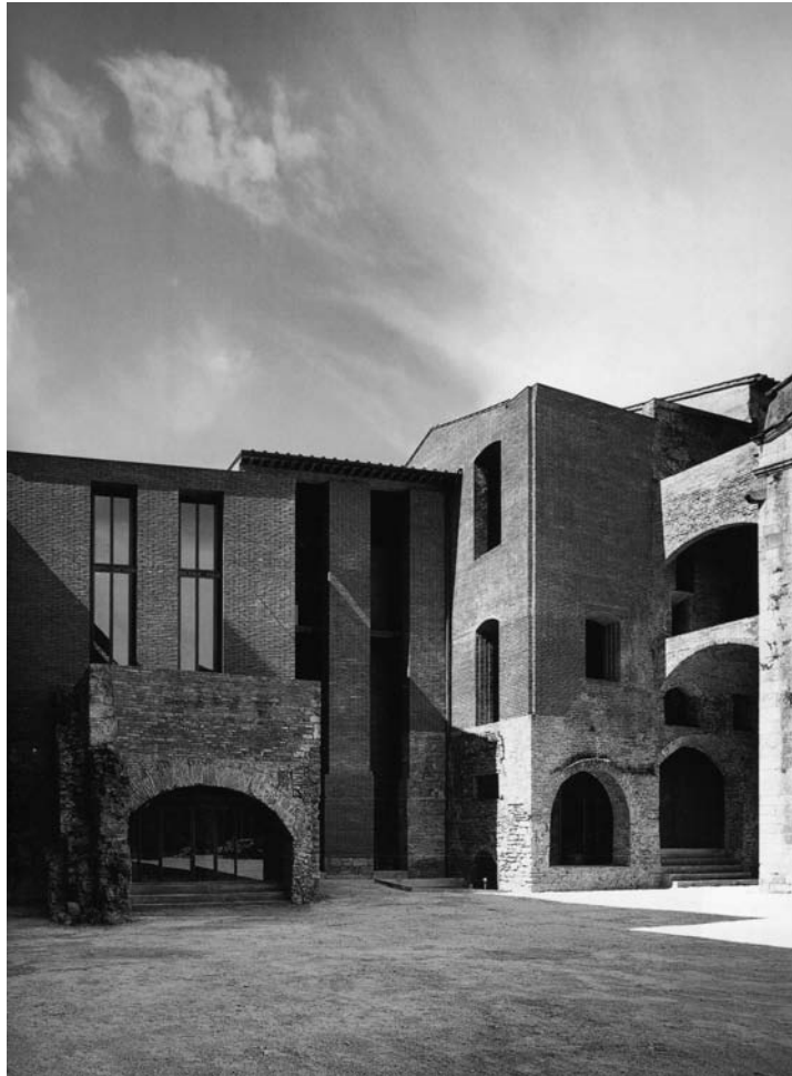
5. Bologna, Oratorio dei Filippini, reintegrazione delle lacune dopo l'intervento di Pier Luigi Cervellati (da "L'industria delle costruzioni")
